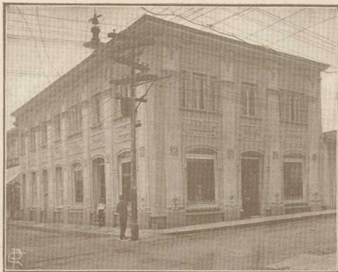
Vista exterior del edificio de la «Nueva Botica de San José, acreditado establecimiento propiedad de don Mariano Jiménez Rojas
